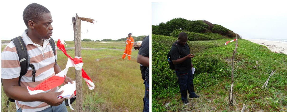
Photo 3. Balisage sommaire du linéaire du câble électrique moyenne tension à construire à Batanga 1
